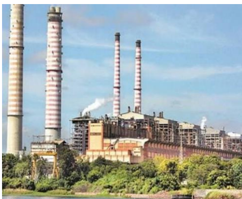
Fig. 3. Kota Super Thermal Power Plant
