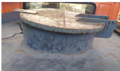
Fig. 2. Water pouring valve
