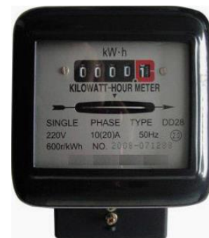
Fig. 1. Analog energy meter
